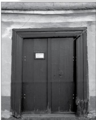
Stav před rekonstrukcí (foto P. Kalousek)
